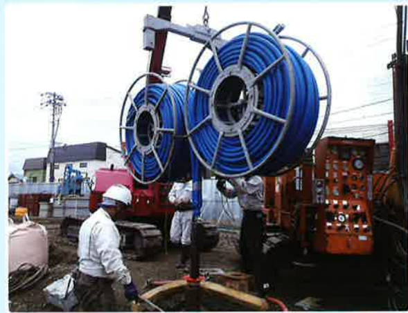
地中熱交換機設置
