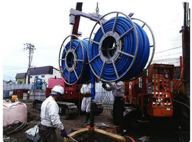
地中熱交換器設置
